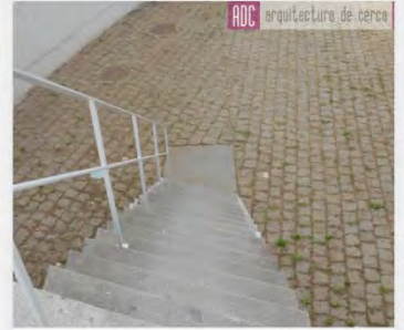
barandilla, chapa, metálica, muro,
