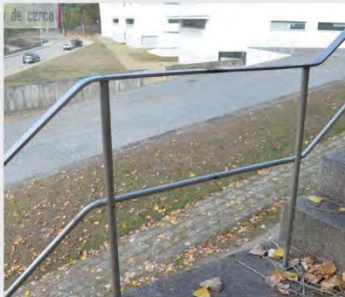
barandilla, metálica, peldaños,
